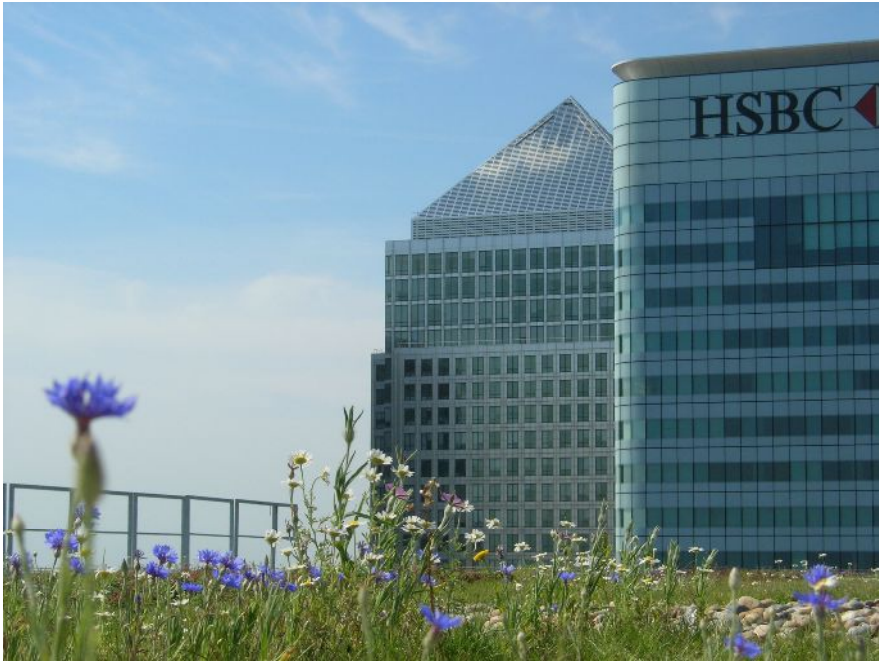
Dak in bloei op 35e verdieping in Londen - Dusty Gedge
