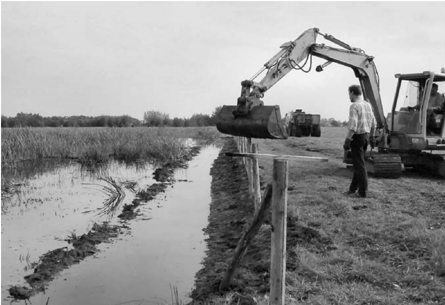
Aanleg moerasstrook langs krabbescheersloot; Rondweg, Zegveld - W. Kruijk
