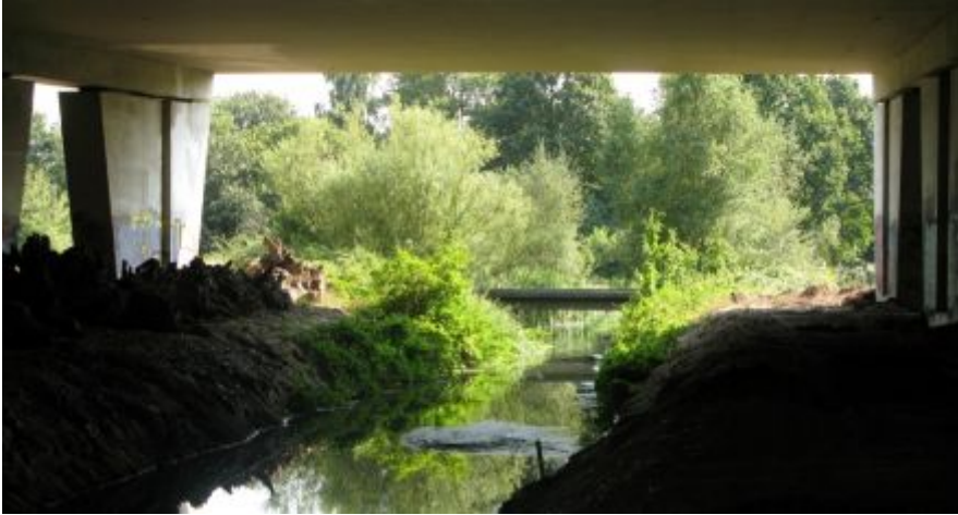
Faunatunnel onder de A28 Zeist-West Oostbroek - Chris Klemann
