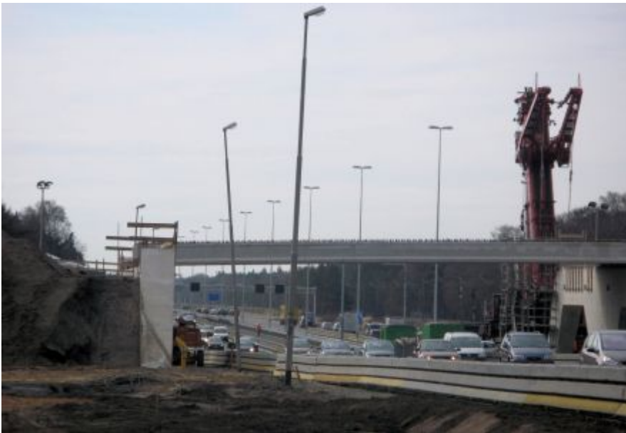
Infrastructuur A12: Ecoduct Mollebos in aanbouw - Chris Klemann
