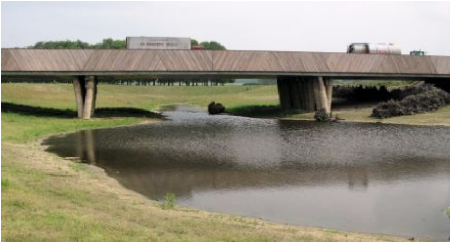
Grote faunatunnel onder de N225 bij de Plantage Willem III - Chris Klemann
