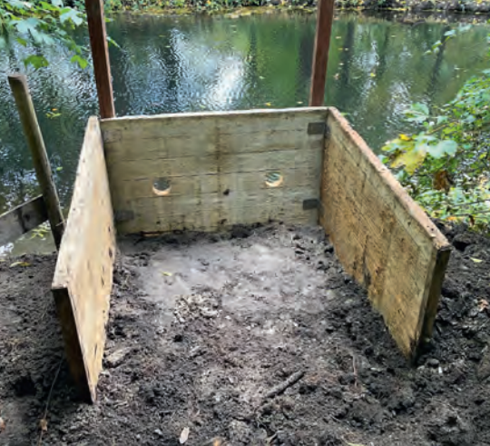
Drie steenschotten vormen de basis van de ijsvogelwand
